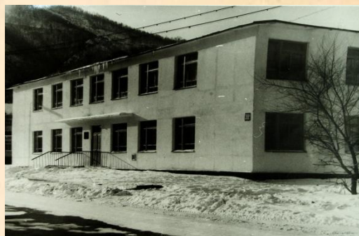
Здание комбината бытового обслуживания по улице Осипенко д.39А п.Дальнегорск, 1973 Ф.88.Оп.2.Д.494
